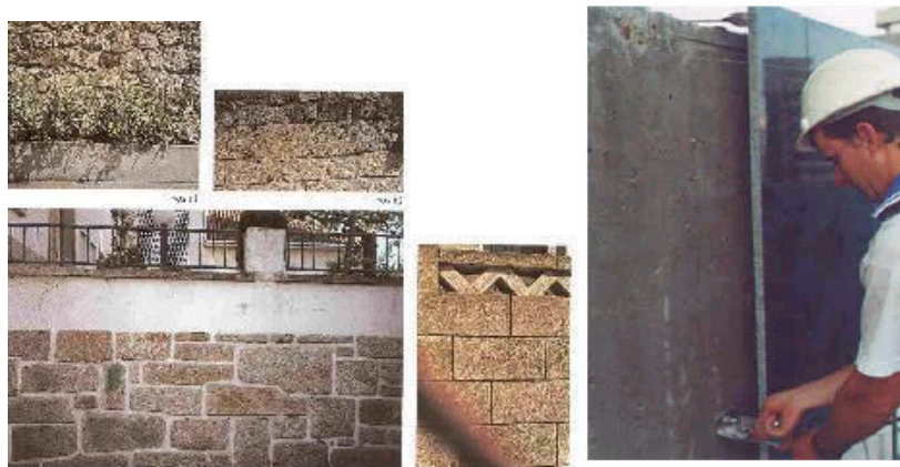
Figura 10 – Muros em pedra maciça granítica, construídos com elementos de formato bruto, semi aparelhados e dimensionados. Fonte: MOURA, A.C. 2000, p.87.
