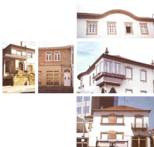
Figura 13 - Aspectos de alguns tipos mais comuns de guarnições de portas e janelas em pedra maciça. Fonte: MOURA, A..C. 2000.p.91.
